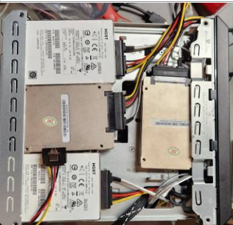
Instalados a las bravas
